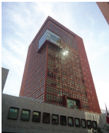
JUZGADOS FAMILIARES, SALAS FAMILIARES Y CONSEJO DE LA JUDICATURA DE LA CIUDAD DE MÉXICO, EDIFICIO UBICADO EN AVENIDA JUÁREZ, 8.
