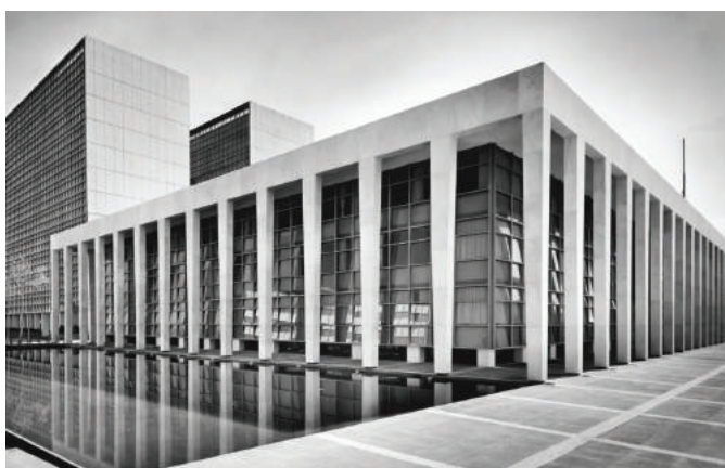
EDIFICIO UBICADO EN NIÑOS HÉROES, 132
